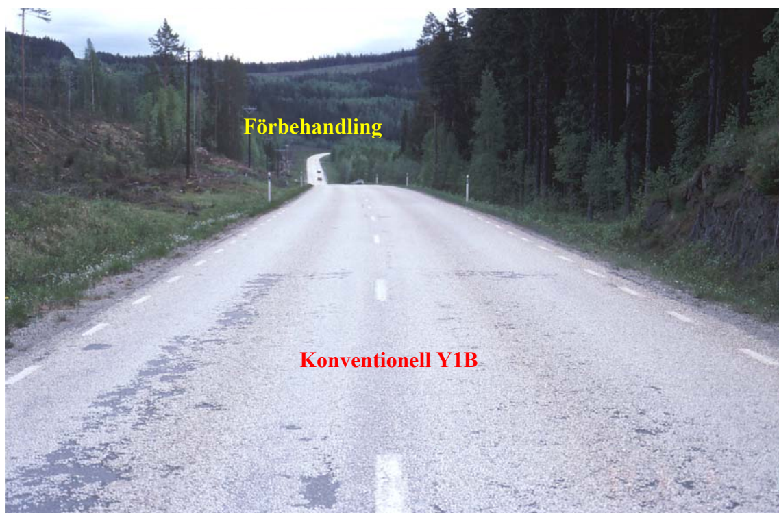
Bild 17: Tydliga resultat av förbehandlad ytbehandlingssten i Jämtland.
