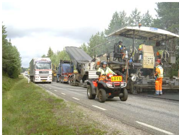
Bild 5: Fyrhjulig motorcykel förekommer som lotsfordon för att den är lätt att vända på vägbanan. Frågan är om den också är ett säkert arbetsfordon på landsvägar.
