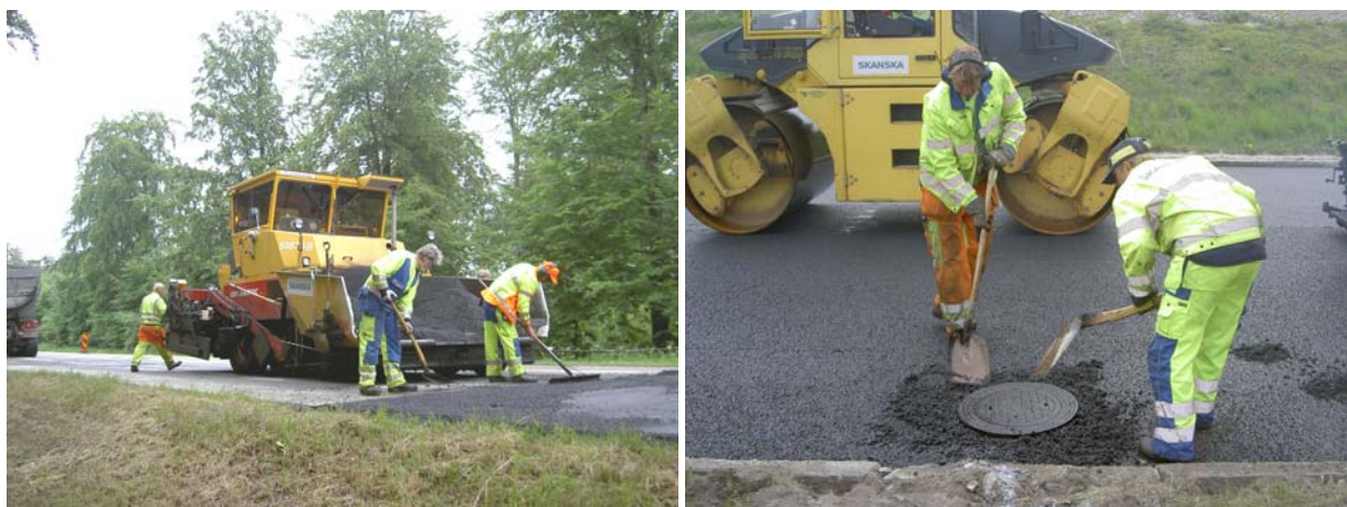
Bild 23: Det mest intensiva handarbetet med asfalt vid maskinläggning sker vid start och stopp och vid brunnar.
