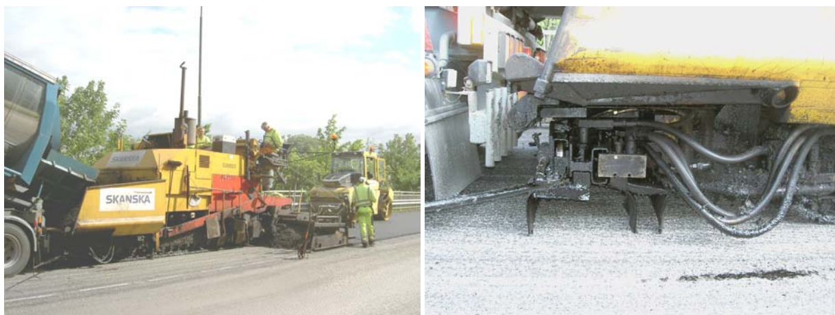
Bild 21: Klisterläggaren lanserades för många år sedan för att ersätta det besvärande klistringsarbetet men också för en specialprodukt, tunnskiktsbeläggning, som idag är den huvudsakliga användningen. Rampen används numera inte till klistring för vanlig asfaltbeläggning.
