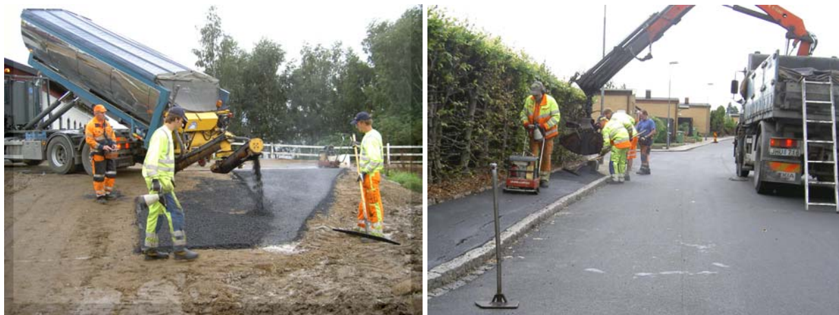
Bild 24: Med god hjälp av en Sprider eller gripskopa återstår "bara" att jämna till och packa asfalten.
