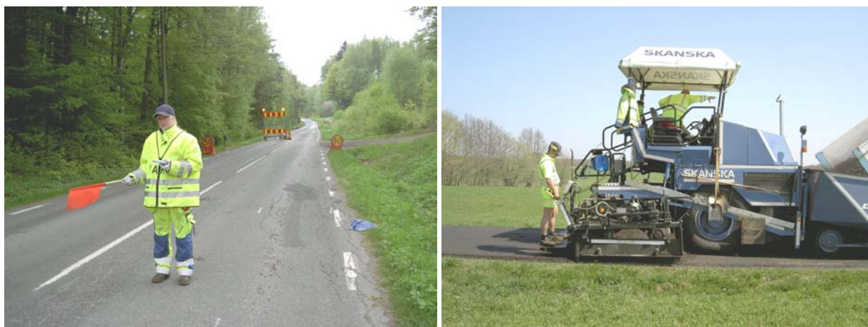
Bild 33: Exempel på färgsättningar som inte kontrasterar särskilt väl mot omgivningarna.
