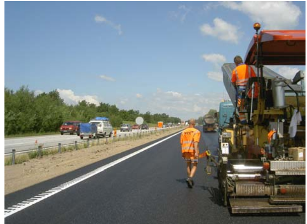
Bild 18: Den sneda kroppsställningen är klassisk bland läggarförare och kommer av maskinens grundkonstruktion.
