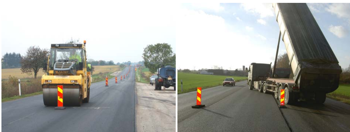
Bild 11: Sidomarkerings-skärmarna gör mest nytta efter första läggardraget men är därefter ett problem för vältar och massabilar. Med trafiklots behövs de inte.
