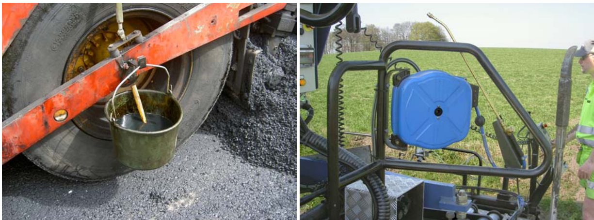
Bild 14: Hinken (med diesel?) och borsten hänger fortfarande med för att de dessvärre behövs. Det finns maskinmonterade sprutor med slangvinda, som sprayar släppmedel där det behövs.
