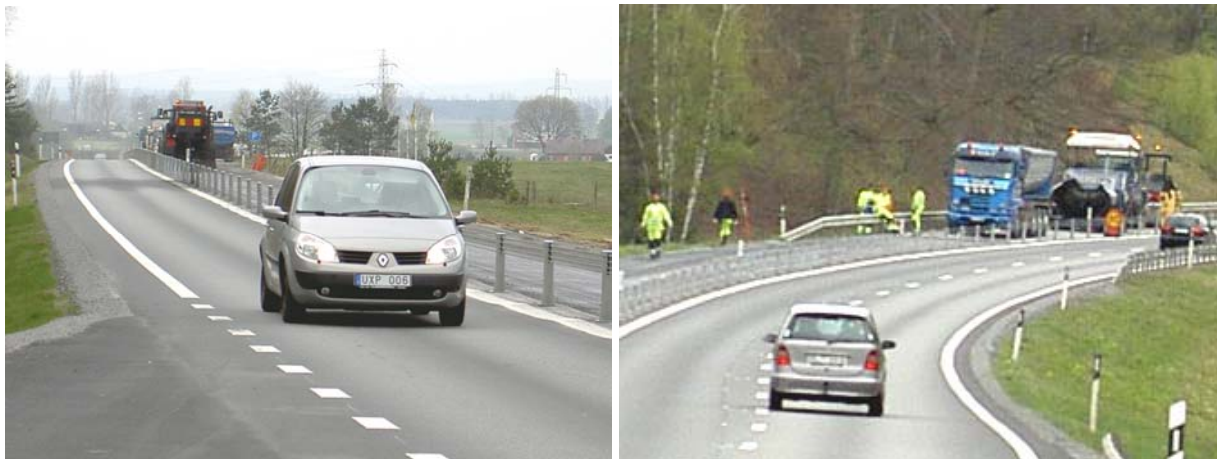
Bild 10: Arbetet sker skyddat mot påkörning men bilarnas höga hastighet (här 70 km/tim) helt nära på andra sidan är en riskfaktor. Lösa föremål kan kastas över och genom mitträcket.
