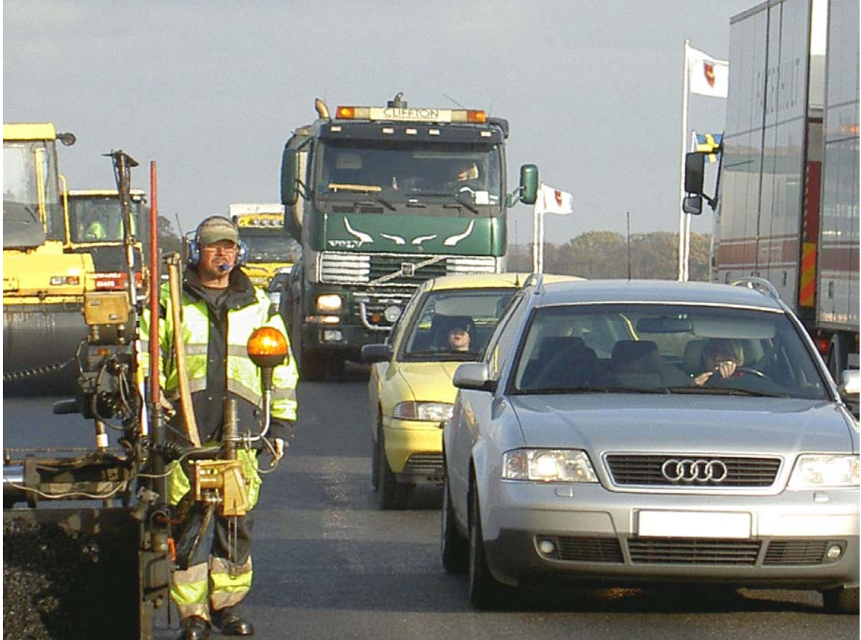
Bild 1: Tusentals fordon kan passera ett beläggningsarbete under en dag. Även om risken för att bli påkörd är mycket liten påminns man ständigt om möjligheten.
