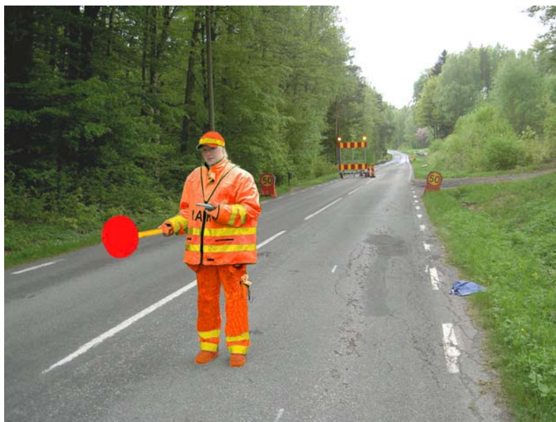
Bild 35: Exempel på färgsättning där alla synliga fält har varslande och kontrasterande färger. Flaggan är utbytt mot ett mer funktionellt signalredskap med grå baksida efter norsk förebild (redigerad bild).
