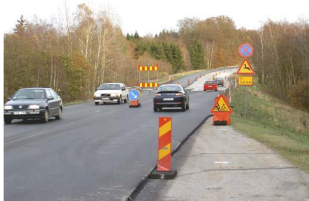
Bild 8: Alla skyltar måste vara korrekt placerade i varje situation. Det är en krävande arbetsuppgift.
