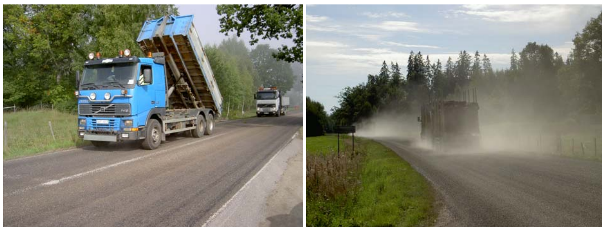
Bild 16: Så länge pågruset är fuktigt är det helt dammfritt men efter ett par timmar börjar det damma och det fortsätter tills allt har blåst bort till omgivningarna .
