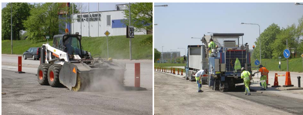
Bild 15: Sopning och fräsning genererar damm, som emellertid kan bekämpas. Damm och partiklar från omgivningarna är svårare att komma åt.
