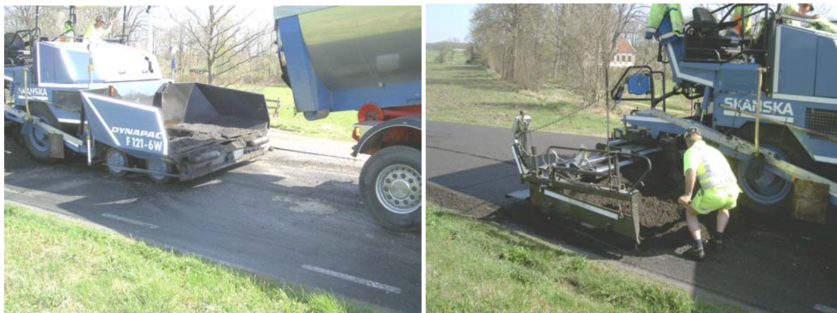
Bild 38: Området framför tråget är den farligaste platsen runt läggaren. Där tas ibland asfaltprover ut men det görs både bättre och säkrare från breddökningen.
