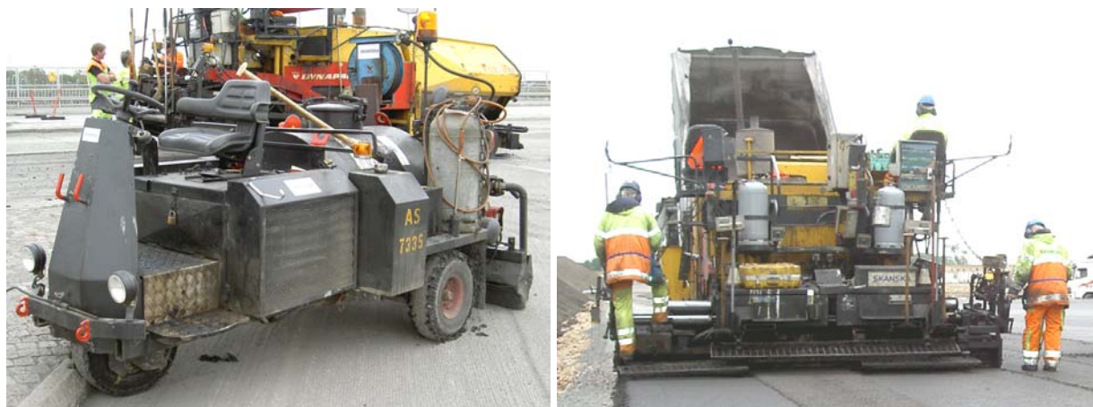
Bild 39: Klistermopedens bitumenbehållare och läggarens screed värms ofta med gas. Det medför en viss brandrisk utöver den tunga hanteringen med gasflaskor. Eluppvärmning är en lösning men det tar tid att ersätta alla gamla maskiner.
