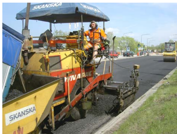
Bild 13: Effektiva asfalttyper kräver ibland högre temperatur förläggbarhetens skull, vilket ökar rök och lukt. Läggarföraren är särskilt utsatt.
